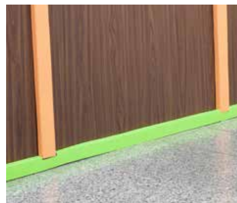
PROTECCIÓN DE ZÓCALO REF 17-129
